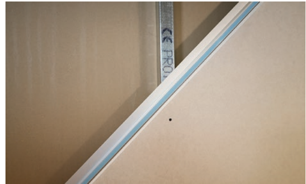
Profil auf der Unterkonstruktion fixiert und nach Herstellerangaben beplankt
