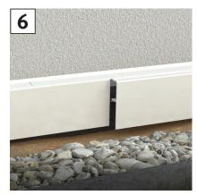
Danach PVC-Abdeckprofil 37527 im gewünschten Farbton aufklipsen. Kabel oder Mikroschlauch kann eingelegt werden.
