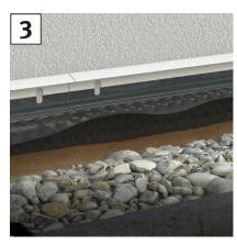
Das Grundprofil 90527 mit der Oberkante entlang der festgelegten späteren GOK ansetzen und fest andrücken. Profil je nach Wunsch mit der weißen oder mit der anthrazitfarbenen Fläche nach oben ankleben. Am Stoß der Einzelstäbe Abstand von 1 - 2 mm belassen.
