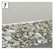
Danach Anschüttung der Kiesdrainage bis zur Profiloberkante.
