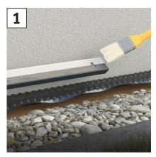
Primer zur Haftungsverbesserung auf Rückseite des zweifarbigen Alu-Grundprofils Protektor 90527 mit einem sauberen Pinsel oder Lappen dünn auftragen. Danach ausreichende Ablüftzeit einhalten.
