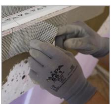
4. Bei Profilstößen ist darauf zu achten, dass diese ausreichend mit dem 10 cm Gewebeüberstand am Stabende überlappt werden.
