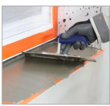
7. Die Dichtschlämme als wasserführende Ebene wird bis zur Weichanbindung des Klebeschenkels geführt. Bei Bedarf die Tropfkantenverlängerung abkleben.
