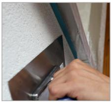
9. Die Tropfenkantenverlängerung kann für das Anbringen einer Schutzfolie verwendet werden, sie schützt zusätzlich die Fensterbank beim Verputzen.
