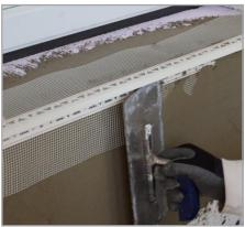
5. Gewebe überspachteln und ausreichend in den Armierungsputz einbetten, Flächengewebe bis an die Tropfkantenverlängerung hoch führen.
