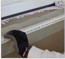
3. Ansetzmaterial vorlegen, Profil an der Brüstung platzieren und ausrichten, Profil gleichmäßig eindrücken, durchquellendes Material verstreichen.
