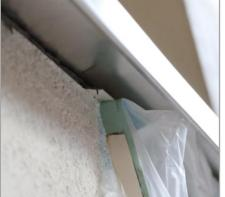
10. Die Tropfenkantenverlängerung kann bei Bedarf nach Beendigung der Putzarbeiten (z.B. bei farbigen Fensterbank- und Putzsystemen) an der Sollbruchstelle entfernt werden.
