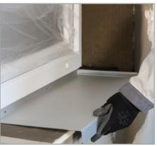
8. Nach Trocknung der Dichtschlämme Einbau der Fensterbank nach Herstellervorgaben des Fensterbanksystems. Je nach System kann der Einbau erst nach Beendigung der Verputzarbeiten erfolgen.
