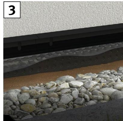
Das Grundprofil 90527 mit der Oberkante entlang der festgelegten späteren GOK ansetzen und fest andrücken. Profil der Fläche nach oben ankleben. Am Stoß der Einzelstäbe Abstand von 1 - 2 mm belassen.
