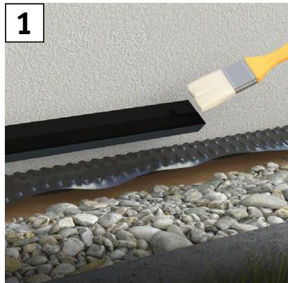
Primer zur Haftungsverbesserung auf Rückseite des Alu-Grundprofils Protektor 90527 mit einem sauberen Pinsel oder Lappen dünn auftragen. Danach ausreichende Abluftzeit einhalten.
