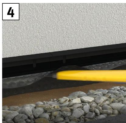
Nach ca. 1 Tag Trocknungszeit die Noppenbahn entlang der Unterkante des Profils 90527 ungefähr bündig abschneiden.
