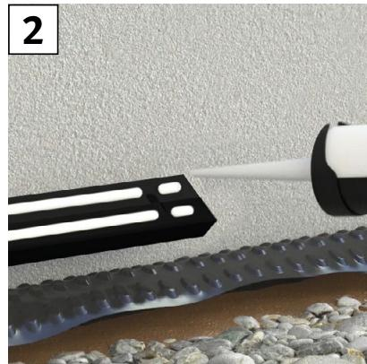
Auf der Rückseite des Grundprofils 90527 zwei parallel verlaufende geradlinige Kleberraupen auftragen (jeweils ca. 5 mm breit, Auftragsmenge in Abhängigkeit von der Untergrundbeschaffenheit).
