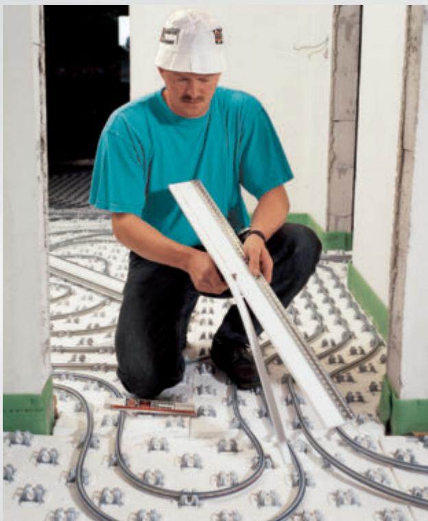
Der PE-Schaumstreifen wird an der Unterkante auf die erforderliche Höhe, entsprechend der Dicke des Estrichs, zurückgeschnitten. Anzeichnen und mit Universalklinge schneiden.
