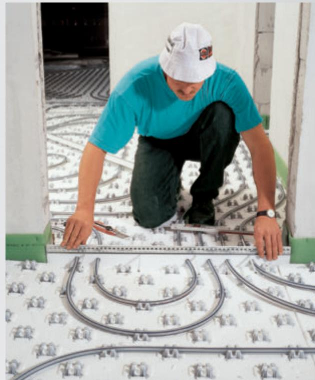
Über die ausgelegten Heizrohre aufstecken und mit Mörtelbatzen fixieren. Dübel in ca. 30 cm Abstand direkt unter der Metallschiene durchstecken.
