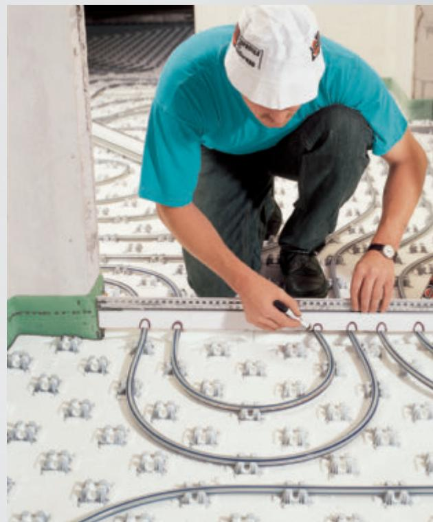
Durchgänge der Heizungsrohre exakt anzeichnen. Bei Anwendung zwischen Türwangen Profil so ablängen, dass es zwischen den Randstreifen leicht eingespannt wird.
