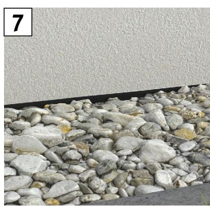
Danach Anschüttung der Kiesdrainage bis zur Profiloberkante.
